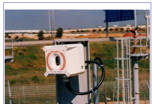
23. ábra: Tartályvédelemre alkalmazott tripla-IR lángérzékelő
