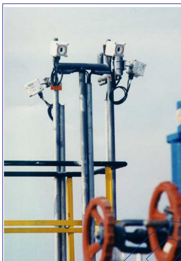
25. ábra: Oszlopon, döntve szerelt tripla-IR lángérzékelő
